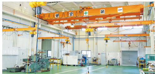
恒温工場 内部
